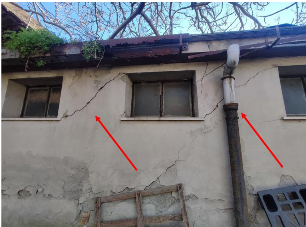
Figura 28. Fessurazioni del prospetto del Fabbricato 67e "lato Sprugola"
