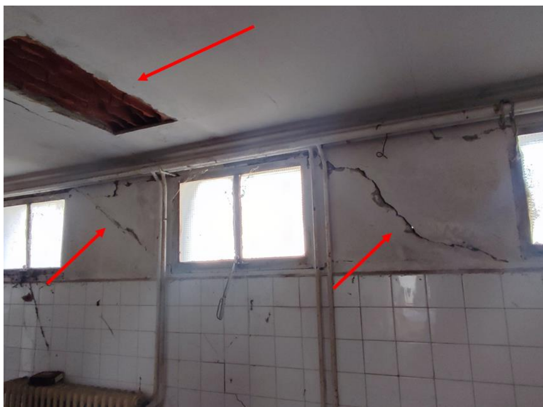
Figura 29. Fessurazioni prospetto del Fabbricato 67e "lato Sprugola", vista dall'interno
