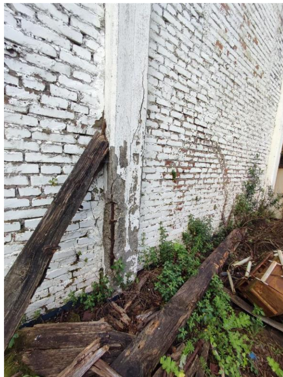
Figura 72. Dettaglio degrado di uno dei pilastri del Fabbricato 111
