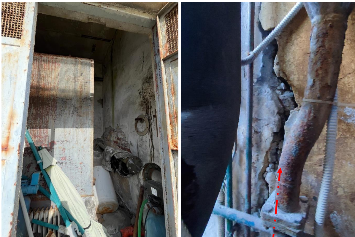
Figura 21. Muro divisorio locale 1D-2D (vista dal locale 2D) e fessura su parete vista dalla centrale termica
