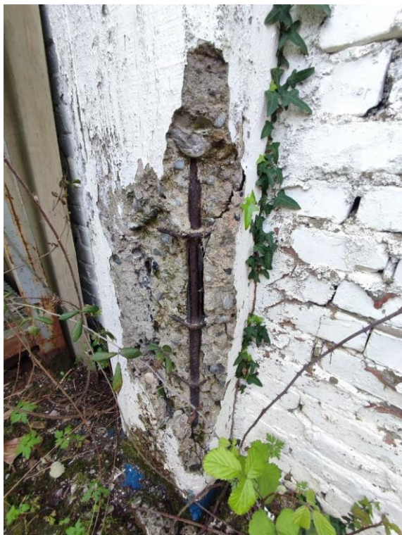
Figura 72. Dettaglio degrado di uno dei pilastri del Fabbricato 111
