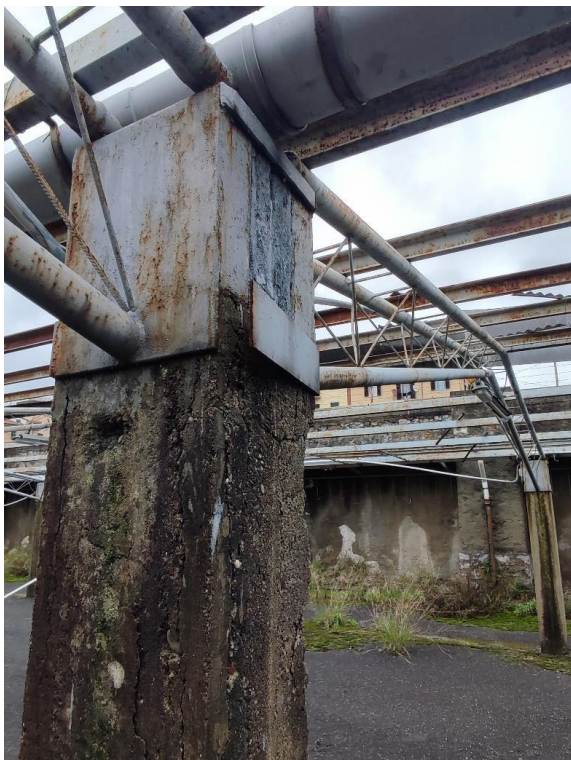
Figura 42. Dettaglio raffigurante la corrosione delle strutture metalliche e travetti ammorsati alla cinta muraria (vincolata)
