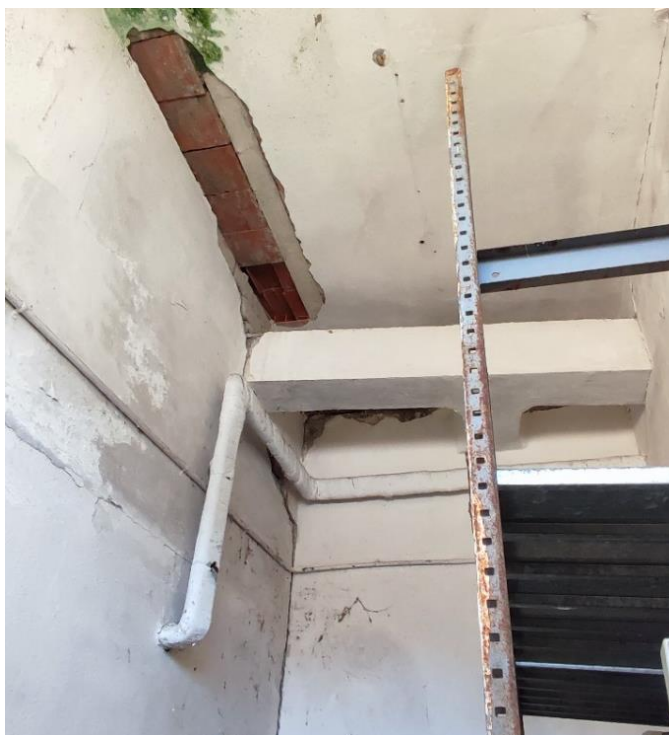
Figura 18. Locale 2D (da demolire) - Trave in c.a. facente parte della cinta muraria (da mantenere)
