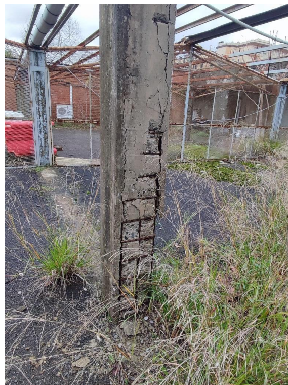
Figura 41. Dettaglio raffigurante il distacco del copriferro dei pilastri di sostegno
