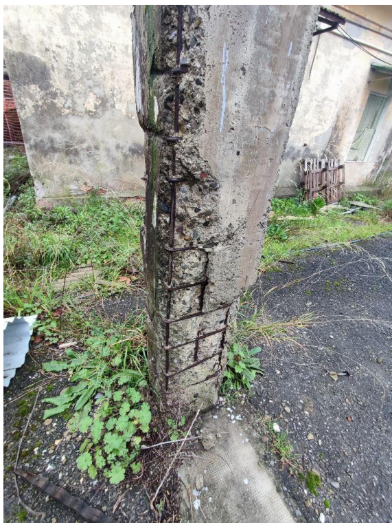
Figura 41. Dettaglio raffigurante il distacco del copriferro dei pilastri di sostegno
