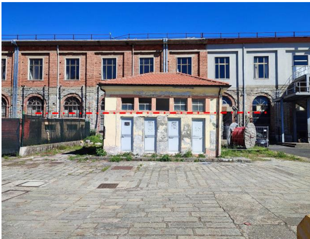
Figura 4. Vista frontale (in evidenza l'inclinazione del manufatto)
